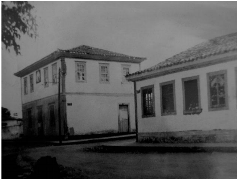
Casa de Câmara e Cadeia. Na parte inferior ficava a Cadeia e na superior a Câmara. Atualmente, nesse local existe o Colégio Estadual “Antesina Santana”. Acervo Museu Histórico de Anápolis.
