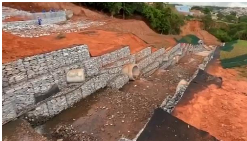
Figura 2 . Obras de contenção de voçoroca na Vila Formosa, Anápolis-GO. Fonte: Jornal Opção, disponível em: https://www.jornalopcao.com.br/ultimas-noticias/prefeitura-de-anapolis-avanca-nas-obras-de-contencao-a-erosao-da-vila-formosa-220131/ , acessado em 25/05/2022 às 14:32.
