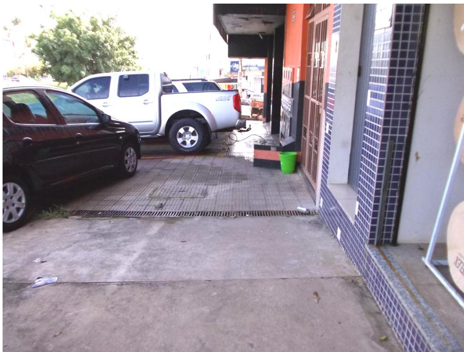
Figura 04. Apropriação do passeio público para usos contrários à circulação de pessoas.
