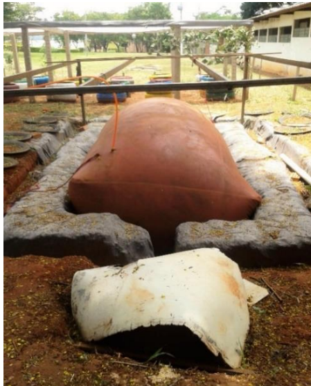
Figura 06. Estado Físico do Biodigestor no dia 06/01/2016.
