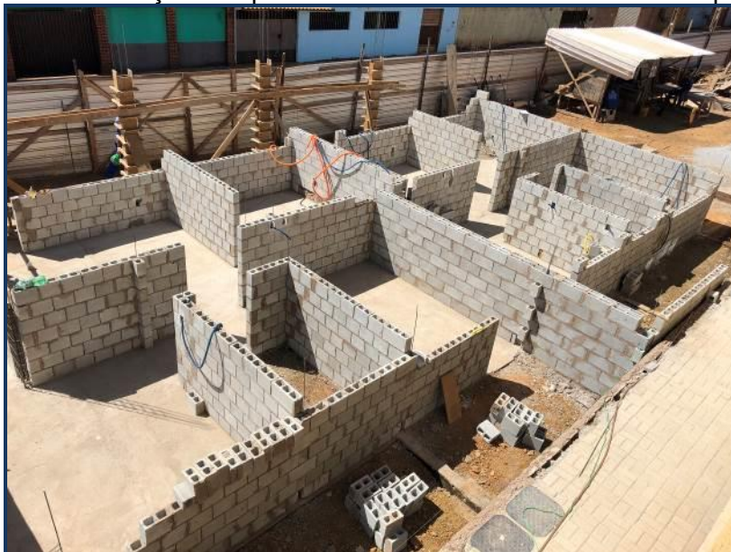
Fonte: Autoria própria (Construção do Condomínio Residencial Park 06)
